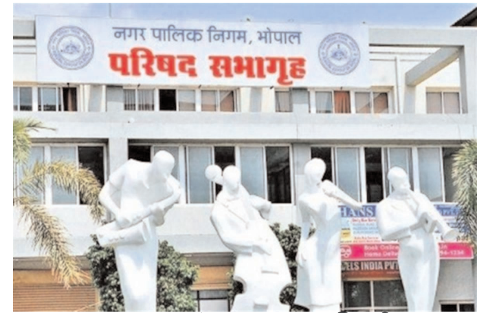
इस योजना के तहत होगा निर्माण
